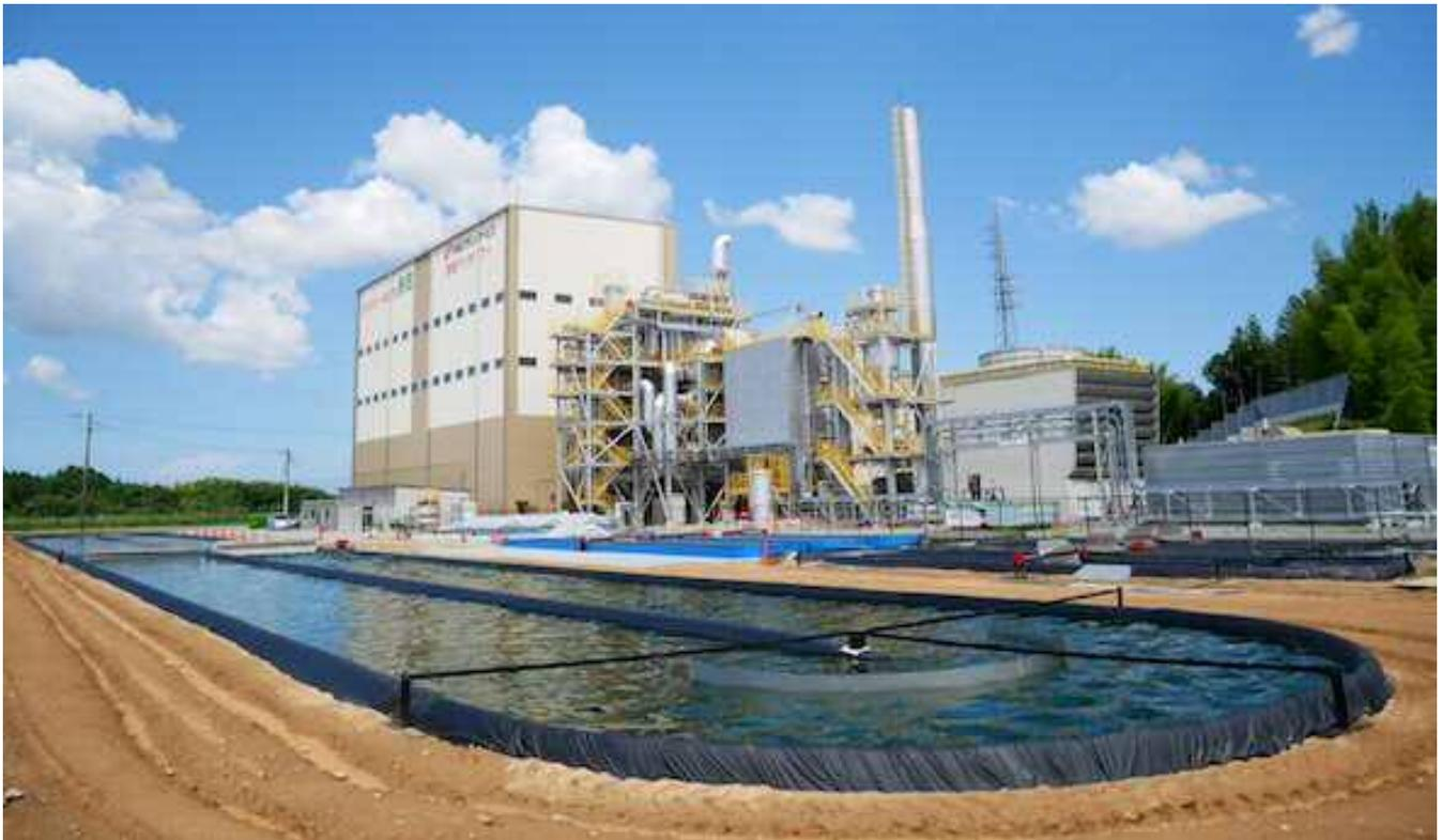
多気バイオパワー（写真奥）からCO<sub>2</sub>、熱、水を隣接する株式会社ユーグレナの藻類エネルギー研究所（写真手前）へ供給し、燃料用微細藻類の研究、培養をしています。
